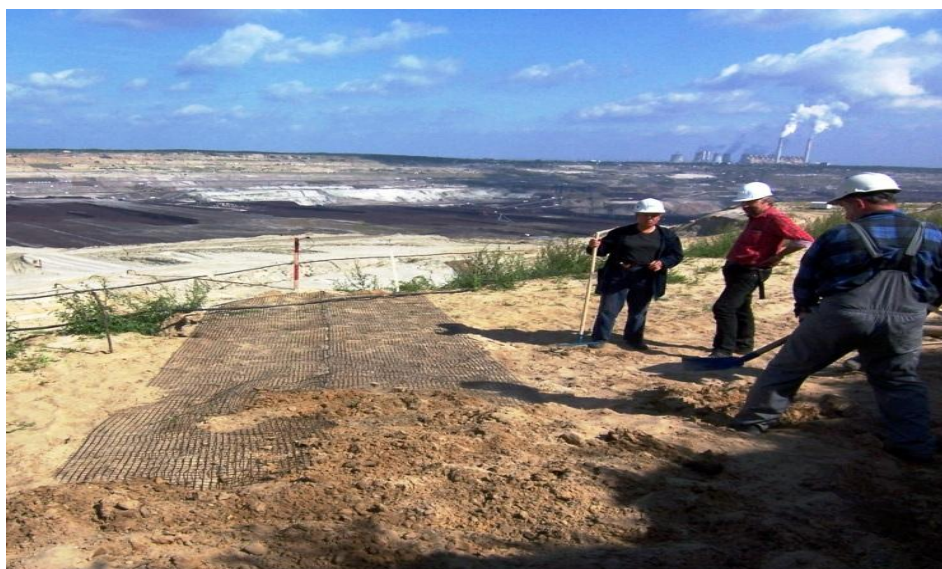
Rys. 7. Instalacja światłowodowej maty pomiarowej, odkrywka Bełchatów.
