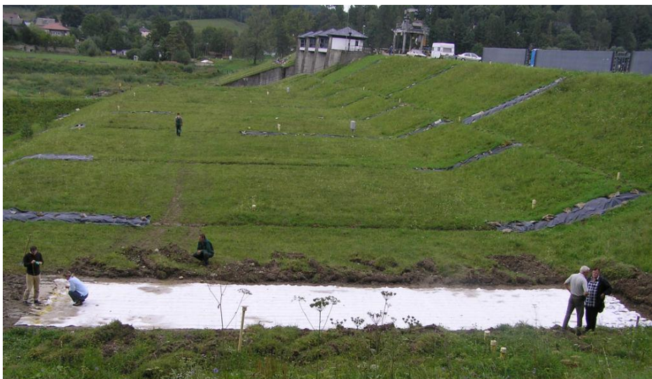
Rys. 6. Instalacja maty pomiarowej, zapora Myczkowce.
